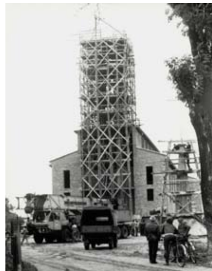
Kościół w trakcie budowy
